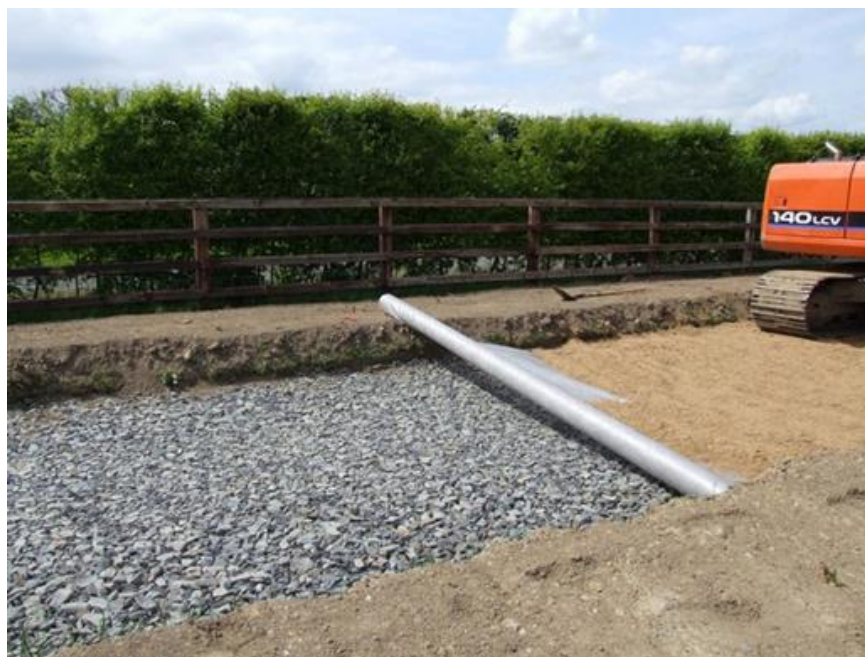
Рисунок 3.34 – Укладка геосинтетического материала
