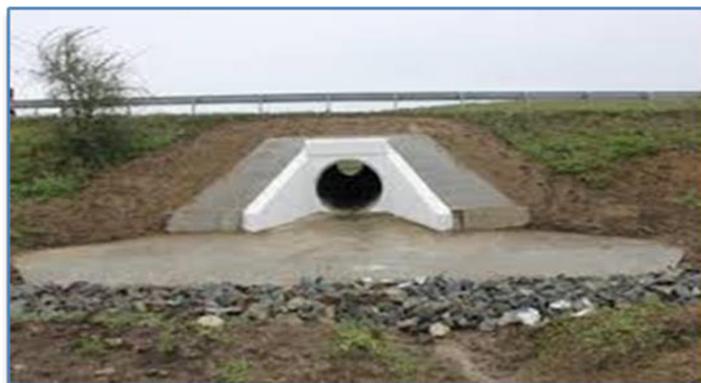
Рисунок 1.4 – Круглая железобетонная труба
