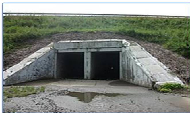
Рисунок 1.5 – Двухочковая прямоугольная труба
