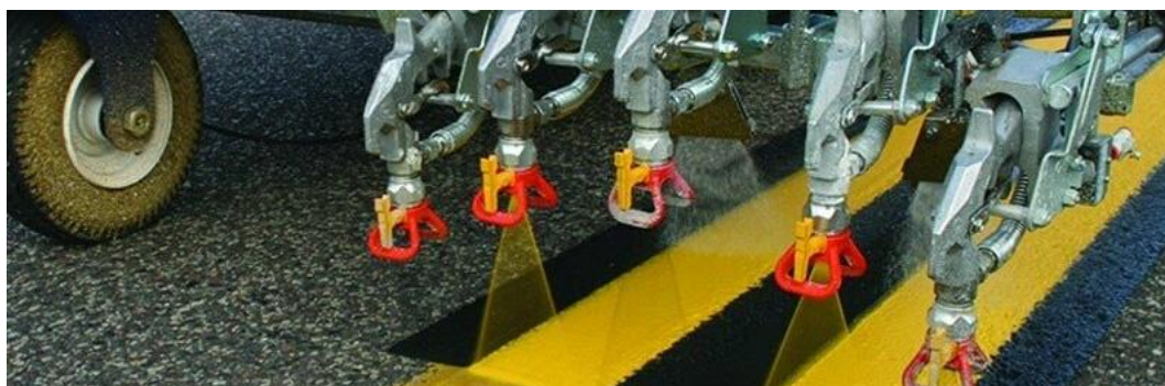
Рисунок 3.36 – Нанесение дорожной разметки
