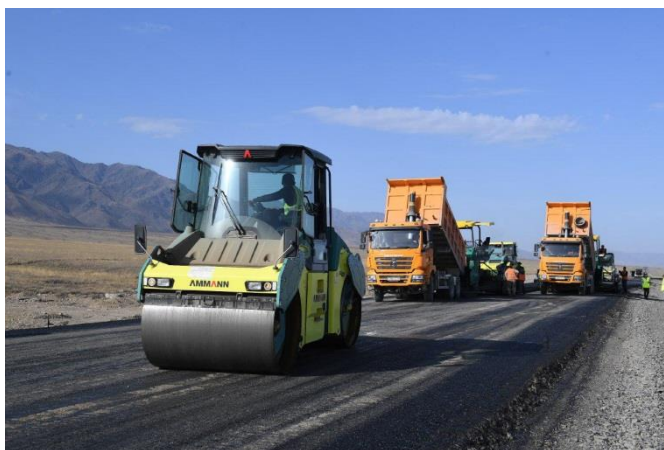
Рисунок 3.37 – Ремонт автомобильной дороги
