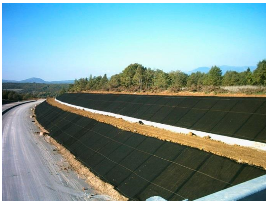
Рисунок 3.20 – Укрепление откосов георешеткой
