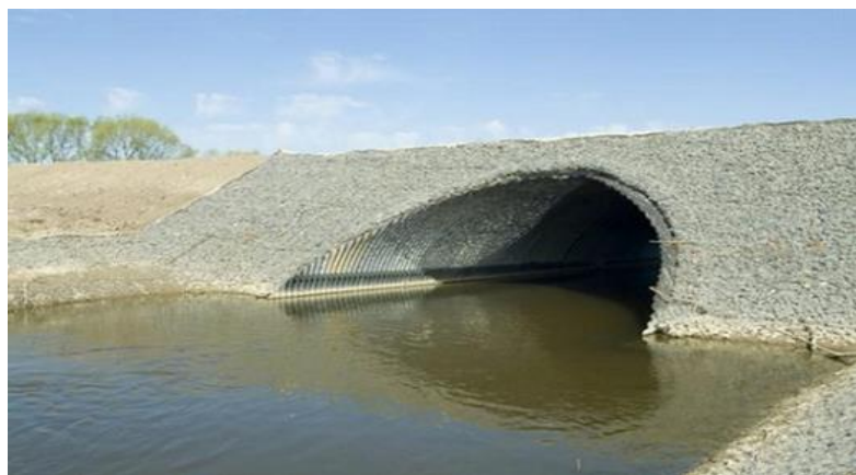
Рисунок 1.6 – Металлическая водопропускная труба
