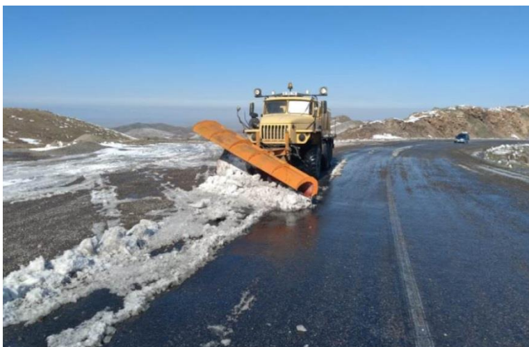
Рисунок 3.39 – Очистка дороги от снега
